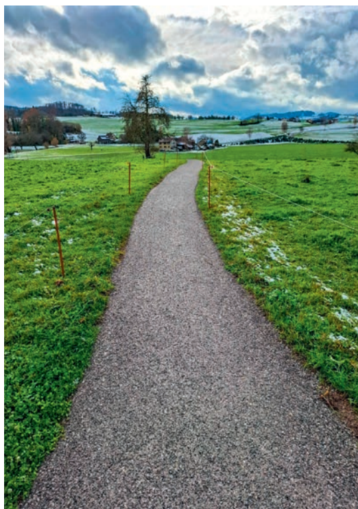
Der Jägerhusweg nach der Sanierung
