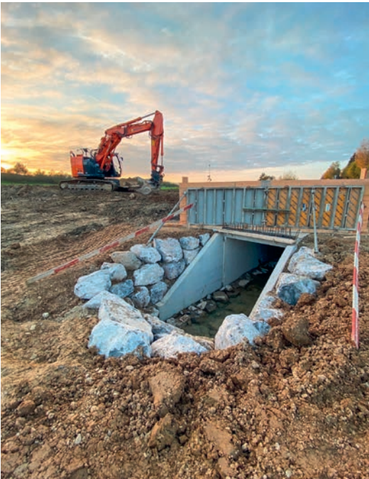
Hochwasserrückhaltebecken Bärensberg im Bau
